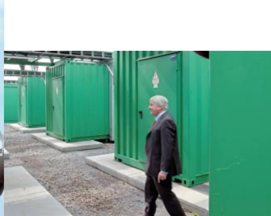
Die vor drei Jahren stillgelegte Zeche Schlägel & Eisen ist heute ein Gelände der Gegensätze: Grüne Container vor alten Backsteingebäuden, glänzende Rohre vor dem rostigen Förderturm. War früher Kohle der Energie-Lieferant ist es heute das Grubengas.
