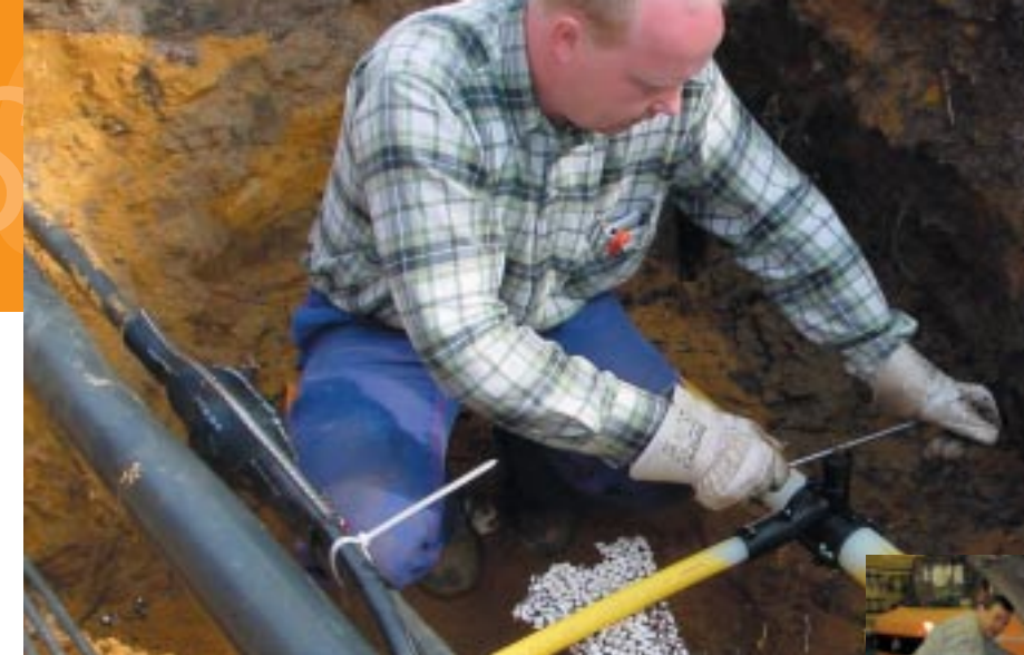
Thomas Lindemann und seine Kollegen sind täglich auf unterschiedlichen Baustellen im Stadtgebiet unterwegs.
