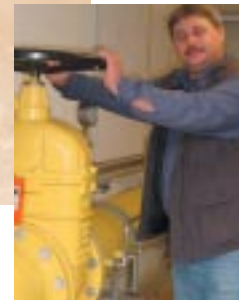
Martin Steckel in der Gas-Übergabestelle auf dem Werksgelände an der Herner Straße.
